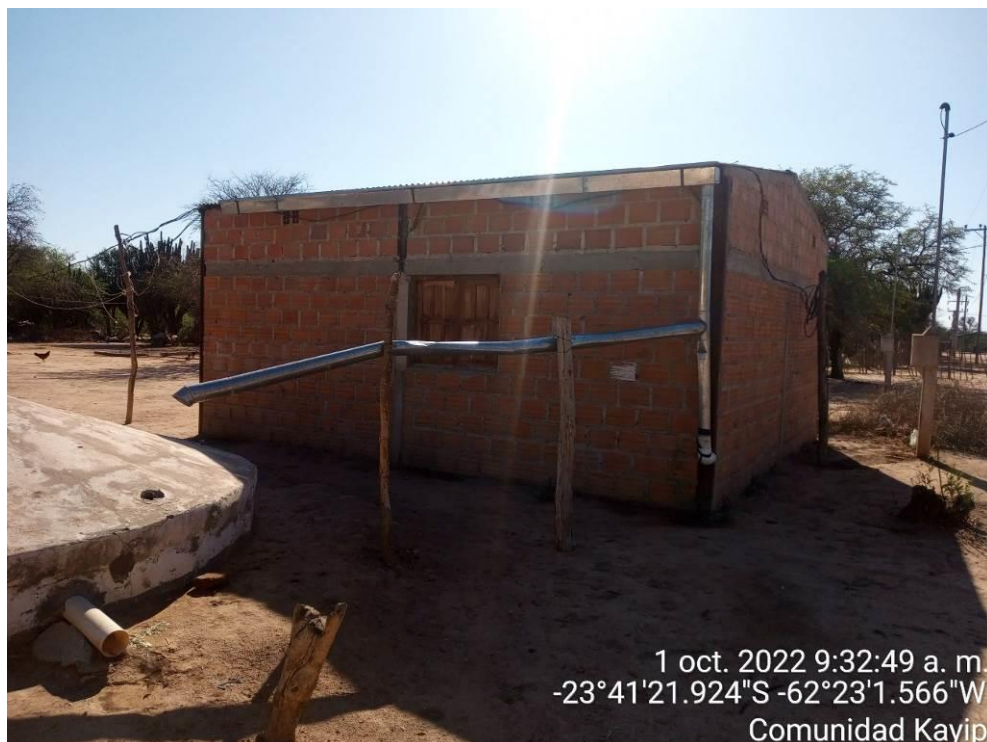
Ilustración 18 Cisterna de Agua.
