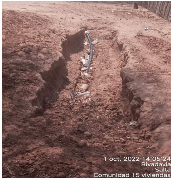
Ilustración 5 Red de agua precaria.
