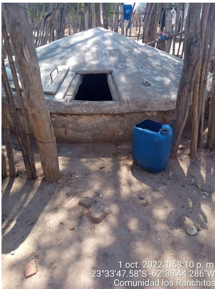
Ilustración 9 Cisterna de agua
