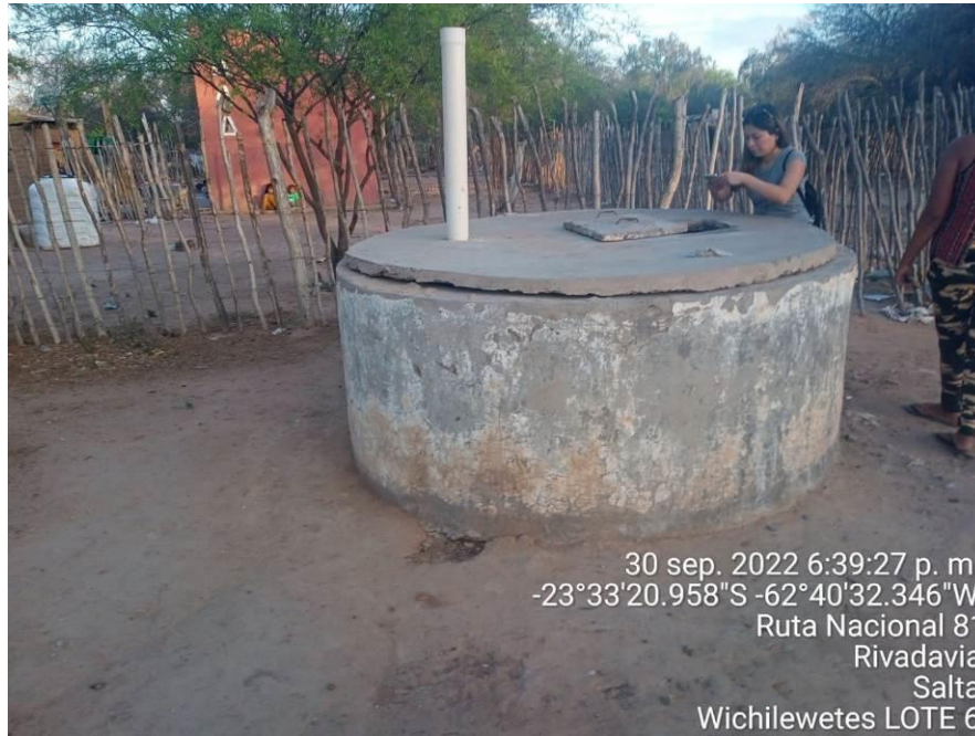
Ilustración 3 Cisterna de Agua.
